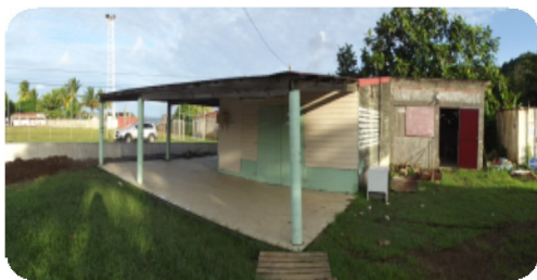
Bâtiment à notre
