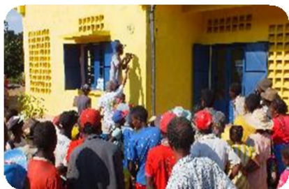
Rénovation du centre de santé
